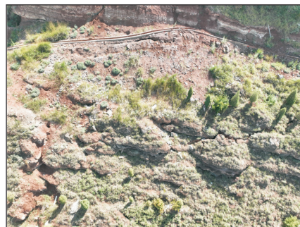
d 坡体裂缝发育
