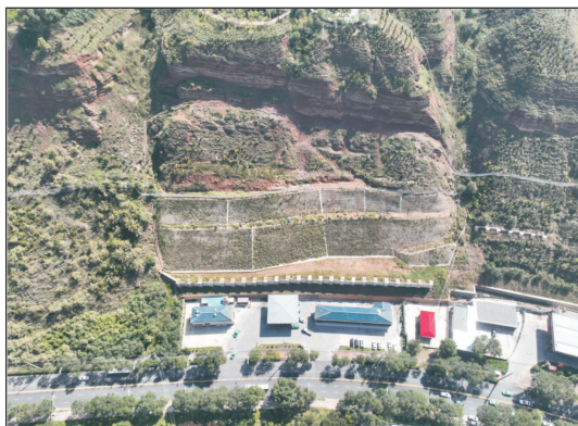
a 滑坡区航拍全貌图(近东西向拍摄, 2023年)
